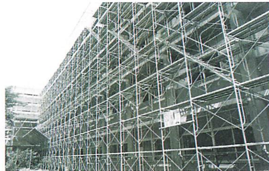
耐震だけでなく全面的に改修工事が行われた。(平成11年)
