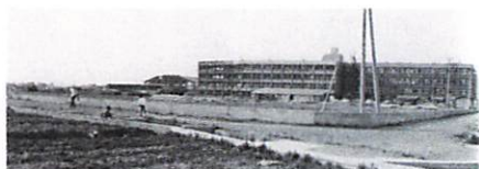
下飯田に建設中の新校舎 (男女共学の1期生として入学しました)
