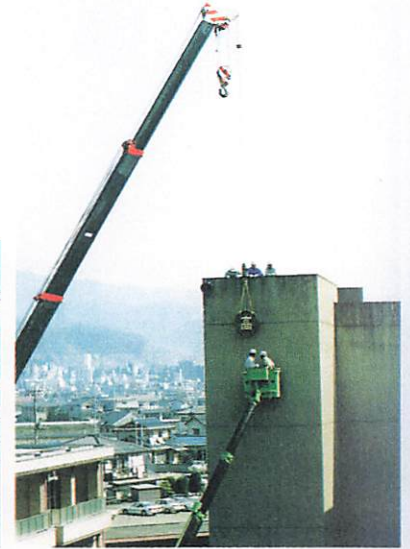
本館正面 校章の取り付け工事(平成4年3月)
